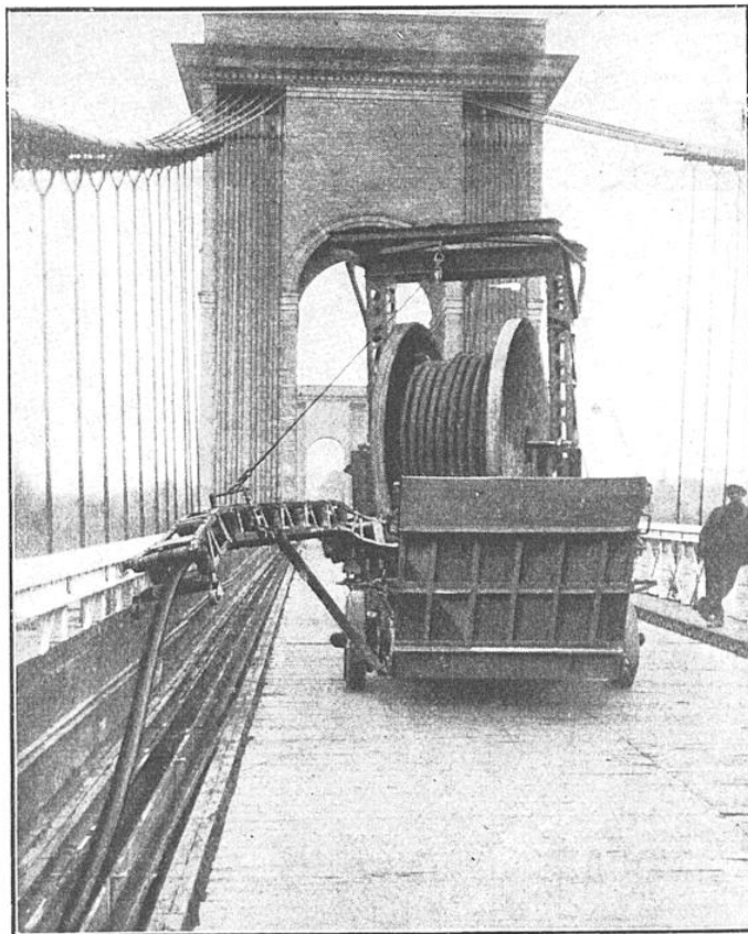
DÉROULEMENT DU CABLE SUR LE PONT DE BOMPAS, SUR LA DURANCE, PRÈS D'AVIGNON
