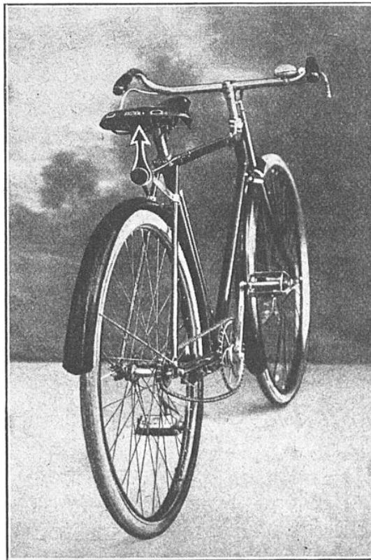
INSTALLÉE A L'ARRIÈRE DE LA BICYCLETTE ET ACTIONNÉE PAR UN LEVIER A PROXIMITÉ DU GUIDON, LA FLÈCHE PERMET D'INDIQUER LES CHANGEMENTS DE DIRECTION SANS LACHER LE GUIDON
