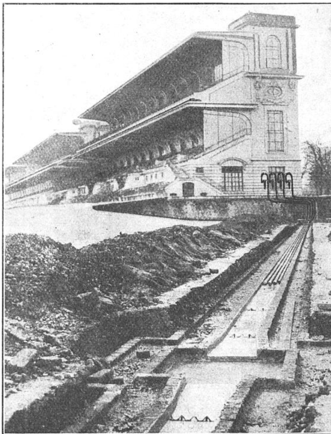
FIG. 9. — AUX TRIBUNES D'AUTEUIL (PARIS) LES LIAISONS SONT DONNÉES PAR TUBES PNEUMATIQUES
