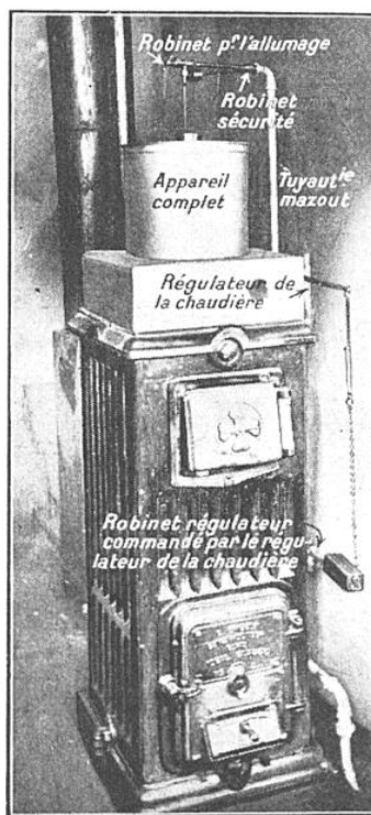
CHAUDIÈRE POUR LE CHAUFFAGE CENTRAL ALIMENTÉE AU MAZOUT
