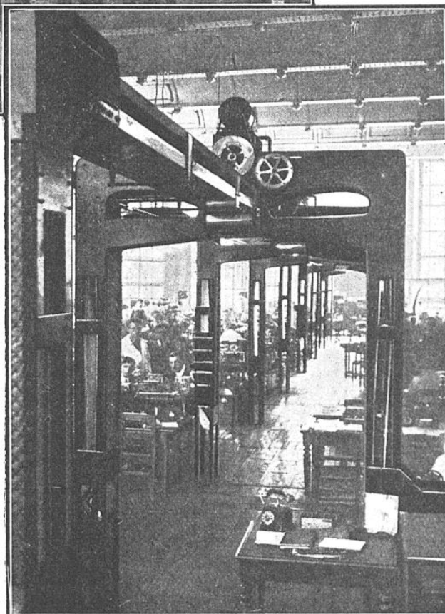
VUE GÉNÉRALE DU TRANSPORTEUR « KRIÉGER » DANS L'UNE DES SALLES DU CENTRAL TÉLÉGRAPHIQUE DE PARIS
