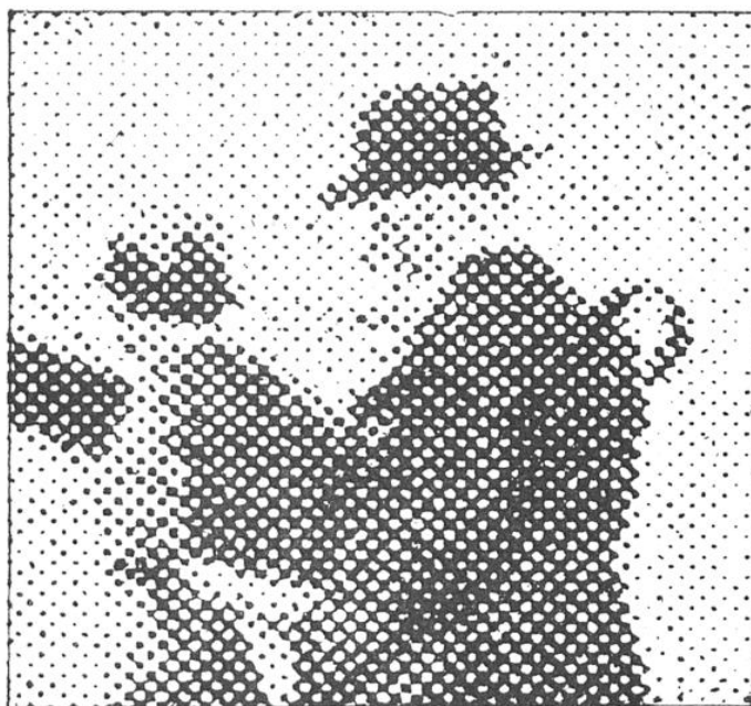
FIG. 1. — LA TRAME DE L'IMAGE REÇUE DANS LE PROCÉDÉ BELL, TELLE QU'ELLE APPARAÎTRAIT DANS UNE PHOTOGRAPHIE UNIQUE (UN SEUL BALAYAGE)
