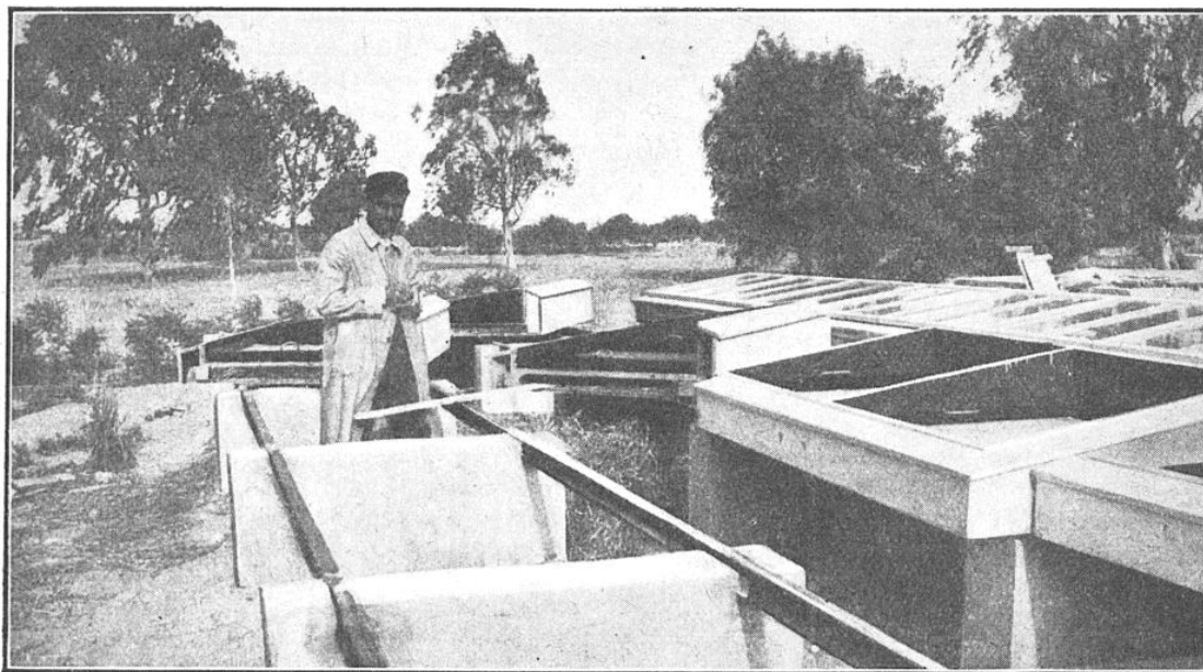
FIG. 4. — LES ÉLÉMENTS DE L'ÉPURATEUR DE BEN-GARDANE (TUNISIE) ONT ÉTÉ MONTÉS PAR GROUPE DE DEUX ET PLACÉS SUR DES MURETTES
