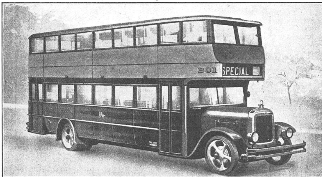
FIG. 3. — LE SYSTÈME « A UN SEUL AGENT », OU LE PRIX DES PLACES EST PERÇU A LA MONTÉE DES VOYAGEURS PAR LE CONDUCTEUR, PEUT ÊTRE APPLIQUÉ MEME AUX GRANDS AUTOBUS A IMPÉRIALE, COMME LE MONTRE LA VUE CI-DESSUS
