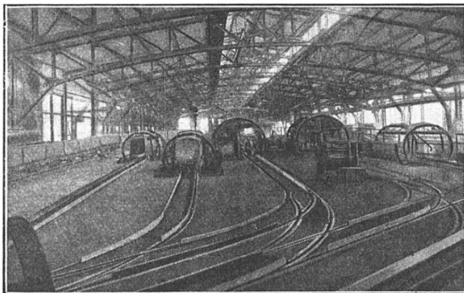
LES CULBUTEURS DU CRIBLAGE
