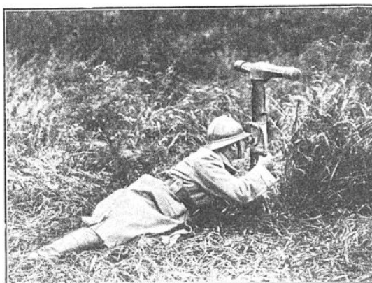
FIG. 9. — TÉLÉMÈTRE PÉRISCOPIQUE A COINCIDENCE DE 0 M. 50 DE BASE EN SERVICE SUR SON PIED
