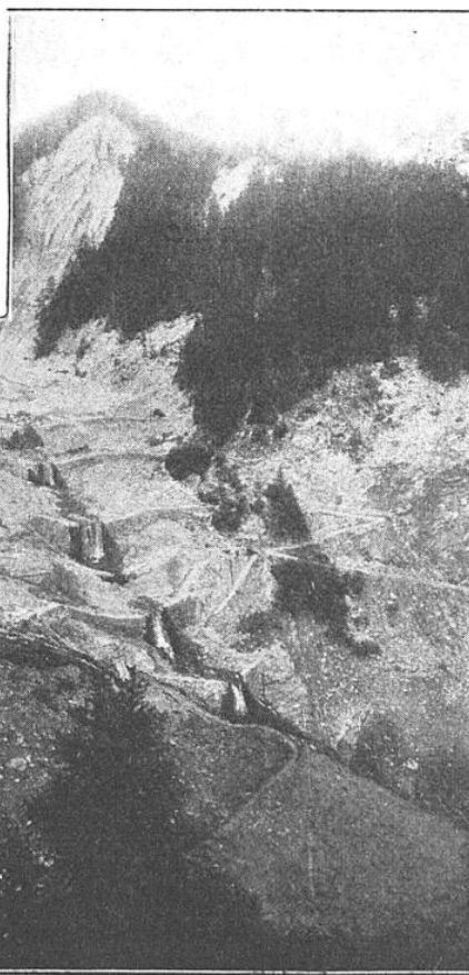
BARRAGE DE FIXATION DE MATÉRIAUX ENTRAÎNÉS CONSTAMMENT DANS LE RAVIN DES ARANDELLYS (TORRENT DE LA GRIAZ)
