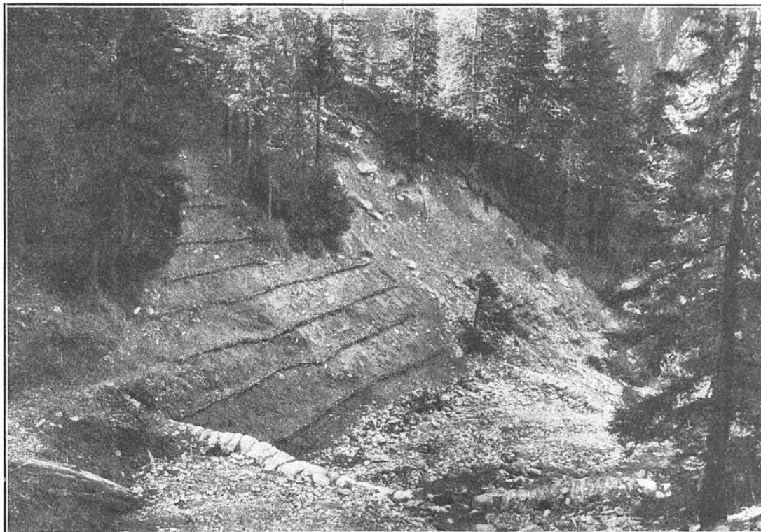
APRÈS LA CORRECTION DU TORRENT DU CHARMAIX, LE CLAYONNAGE ET L'ENHERBEMENT DES BERGES ONT FIXÉ LES TERRES
