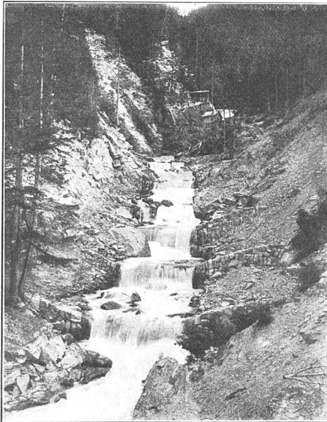
GRACE A DES BARRAGES SUCCESSIFS, LE COURS DU TORRENT DU CHARMAIX, AFFLUENT DE L'ARC (SAVOIE), A ÉTÉ RÉGULARISÉ ET SES BERGES ONT PU ÊTRE REBOISÉES
