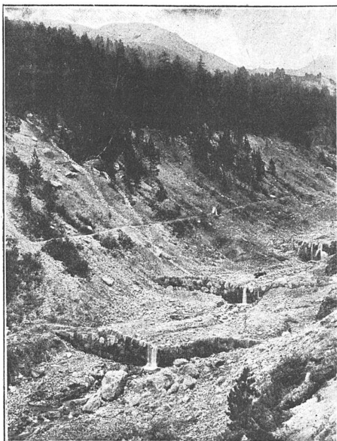
UN DRAINAGE SERRÉ A PERMIS DE FIXER LA BERGE RIVE DROITE DU TORRENT DE SAINT-ANTOINE, PRÈS DE MODANE (SAVOIE)
