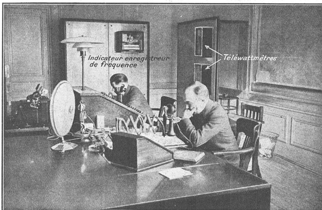
FIG. 5. — LE BUREAU DU « DISPATCHING » : AU FOND, LES APPAREILS DE MESURE
