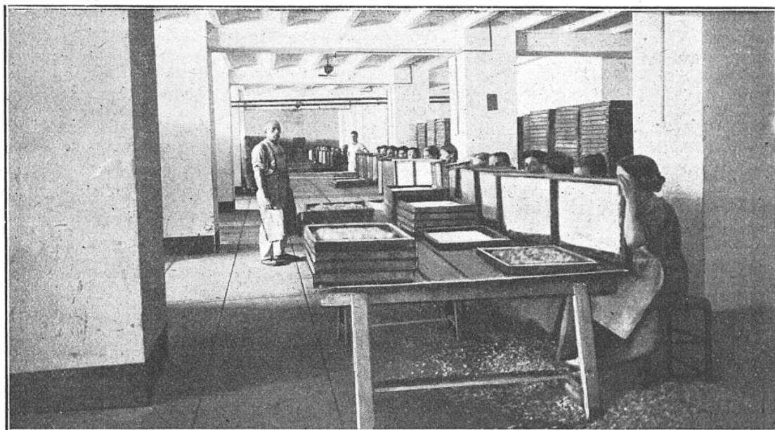
FIG. 4. — L'ENFLEURAGE SUR CHASSIS (JASMIN) CONSISTE À REMPLACER CHAQUE JOUR LES FLEURS QUI, DEPUIS LA VEILLE, ÉTAIENT EN CONTACT AVEC LA GRAISSE (ABSORBANT DU PARFUM) PAR DE NOUVELLES FRAICHEMENT CUEILLIES.
