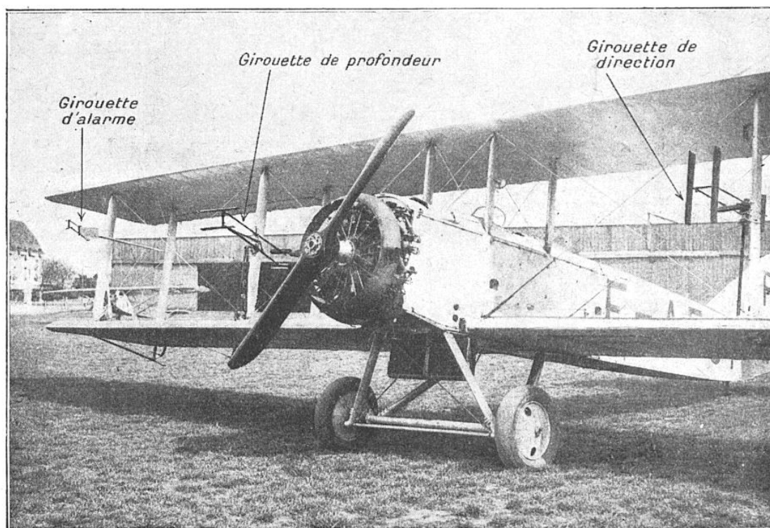
FIG. 4. — L'AVION FARMAN « F-71 » ÉQUIPÉ DE DEUX GIROUETTES STABILISATRICES (VOIR LE DÉTAIL PLUS LOIN) ET D'UNE GIROUETTE D'ALARME
