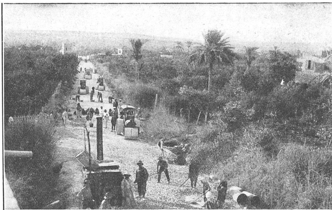
CONSTRUCTION DE LA ROUTE BEYROUTH-NAKOURA SUR LA COTE DE LA MÉDITERRANÉE (LIBAN) On remarquera la richesse de la flore méditerranéenne.
