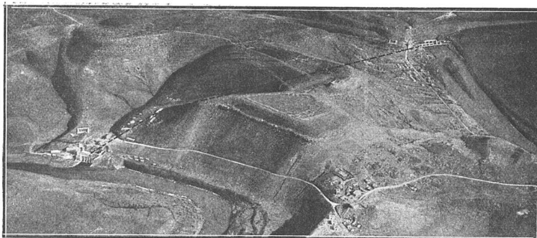
VUE, PRISE A BORD D'UN AVION, DE L'USINE HYDRO-ÉLECTRIQUE DE SIDI-MACHOU A droite et en haut de l'image, le barrage de retenue sur l'oued. A gauche, l'usine proprement dite. En pointillé, la galerie souterraine qui amène l'eau du barrage à l'usine. Longueur : 1.400 mètres.
