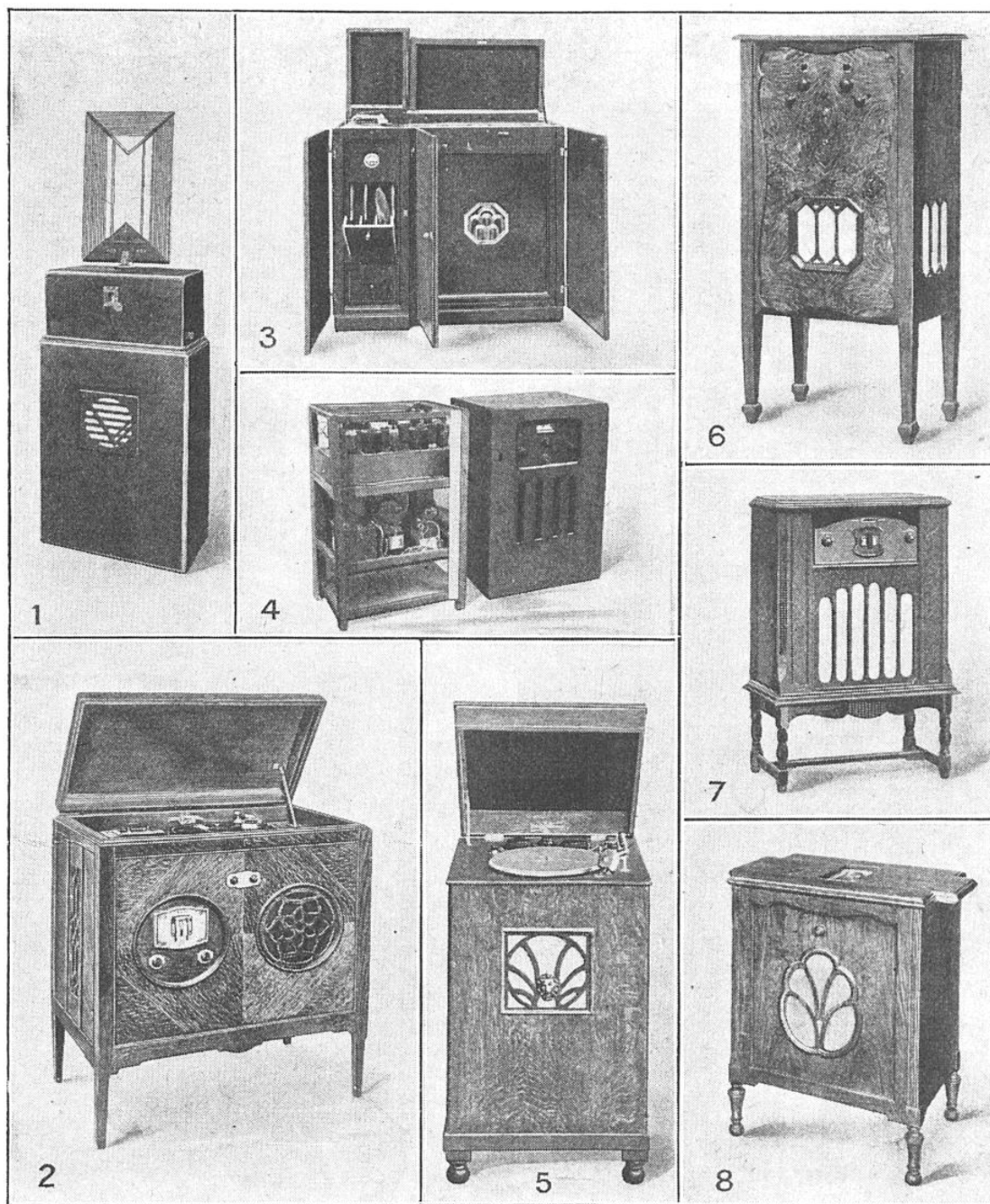
FIG. 9. — 1. RÉCEPTEUR FRANÇAIS A CHANGEMENT DE FRÉQUENCE A GRANDE SENSIBILITÉ, A RÉGLAGE UNIQUE, ALIMENTÉ PAR SECTEUR 2. RADIO-PHONOGRAPHE ALIMENTÉ PAR LE SECTEUR ET COMPRENANT UN RADIO-RÉCEPTEUR TRÈS SENSIBLE A 4 CIRCUITS ACCORDÉS ET 3 LAMPES A ÉCRAN-GRILLE 3. RÉCEPTEUR SENSIBLE A CHANGEMENT DE FRÉQUENCE ET PHONOGRAPHE ÉLECTRIQUE
