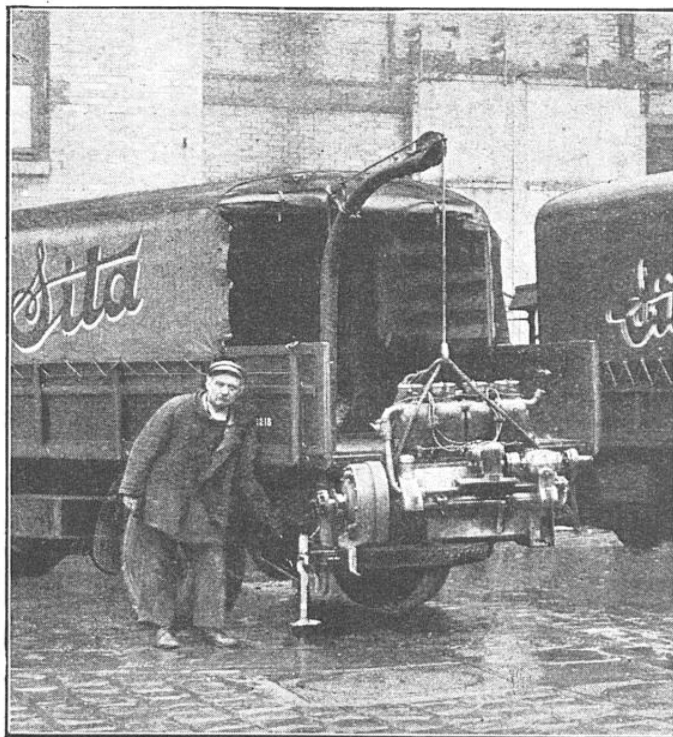
GRACE A LA GRUE PIVOTANTE, LA SIMPLE MANŒUVRE D'UN LEVIER PERMET AU CHAUFFEUR DE CHARGER OU DE DÉCHARGER TOUT SEUL SON CAMION
