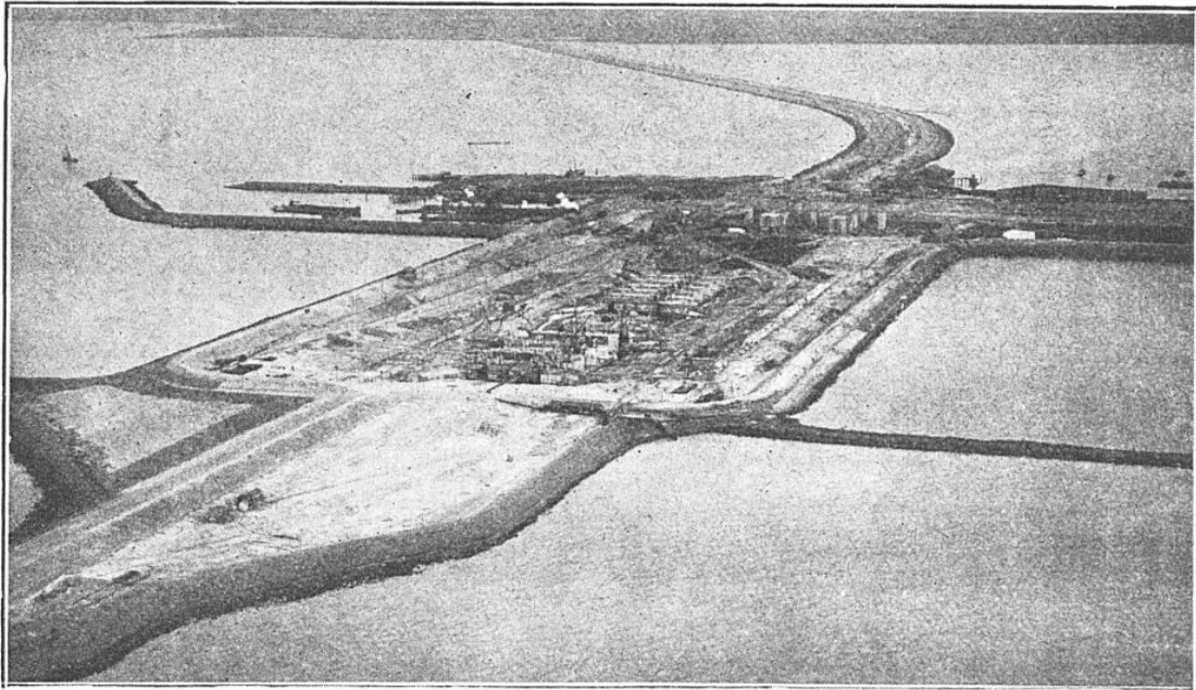
AMORCE DE LA GRANDE DIGUE DE FERMETURE DU ZUYDERZÉE, SUR LE BANC DE KORNWERD, ENTRE LA CÔTE DE FRISE ET L'ÎLE DE WIERINGEN
