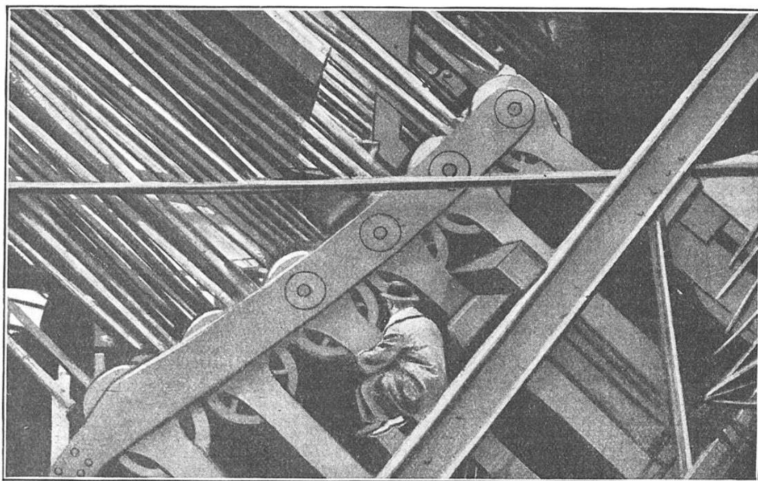
DISPOSITIF D'ANCRAGE D'UN DES CÂBLES DE SUSPENSION DU PONT DE L'HUDSON SUR LA RIVE COTÉ NEW YORK
