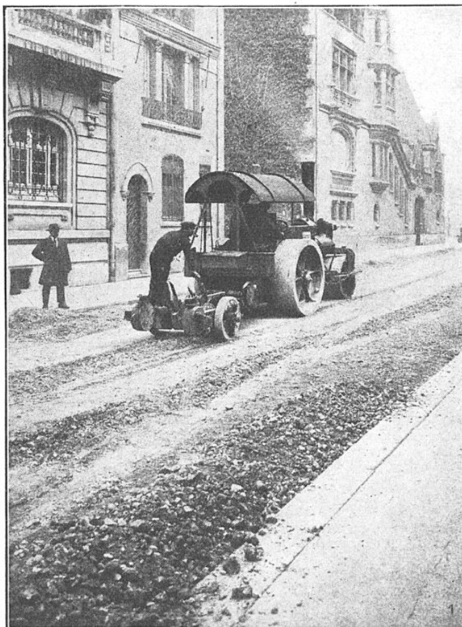
PIOCHEUSE REMORQUÉE PAR UN CYLINDRE A VAPEUR La piocheuse est couramment utilisée aujourd'hui pour remettre en forme les chaussées en mauvais état et corriger les bombements.
