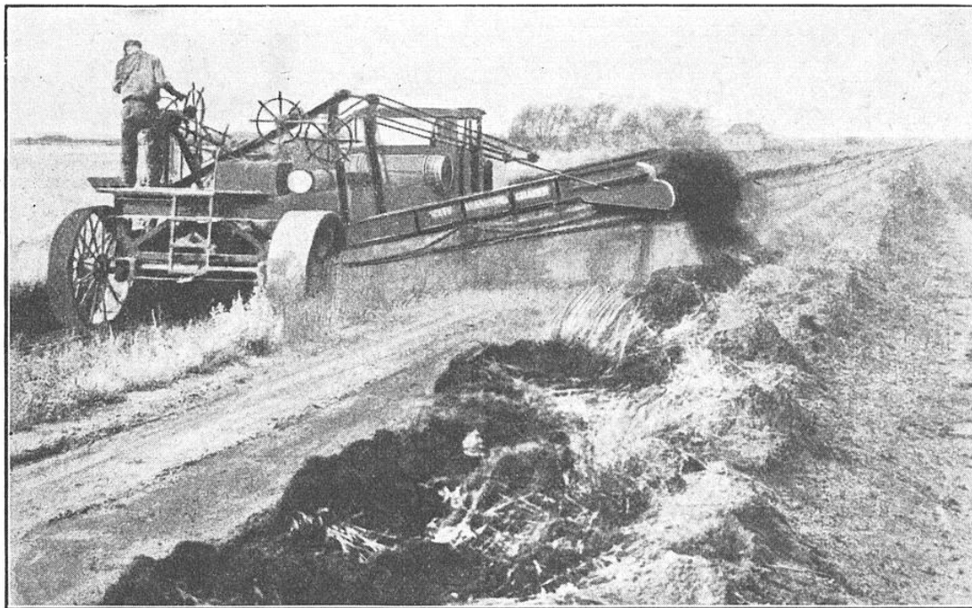
MACHINE DÉCAPEUSE TRANSPORTANT LES DÉBLAIS COURAMMENT UTILISÉS AUX ÉTATS-UNIS POUR LA CONSTRUCTION DE NOUVELLES CHAUSSÉES
