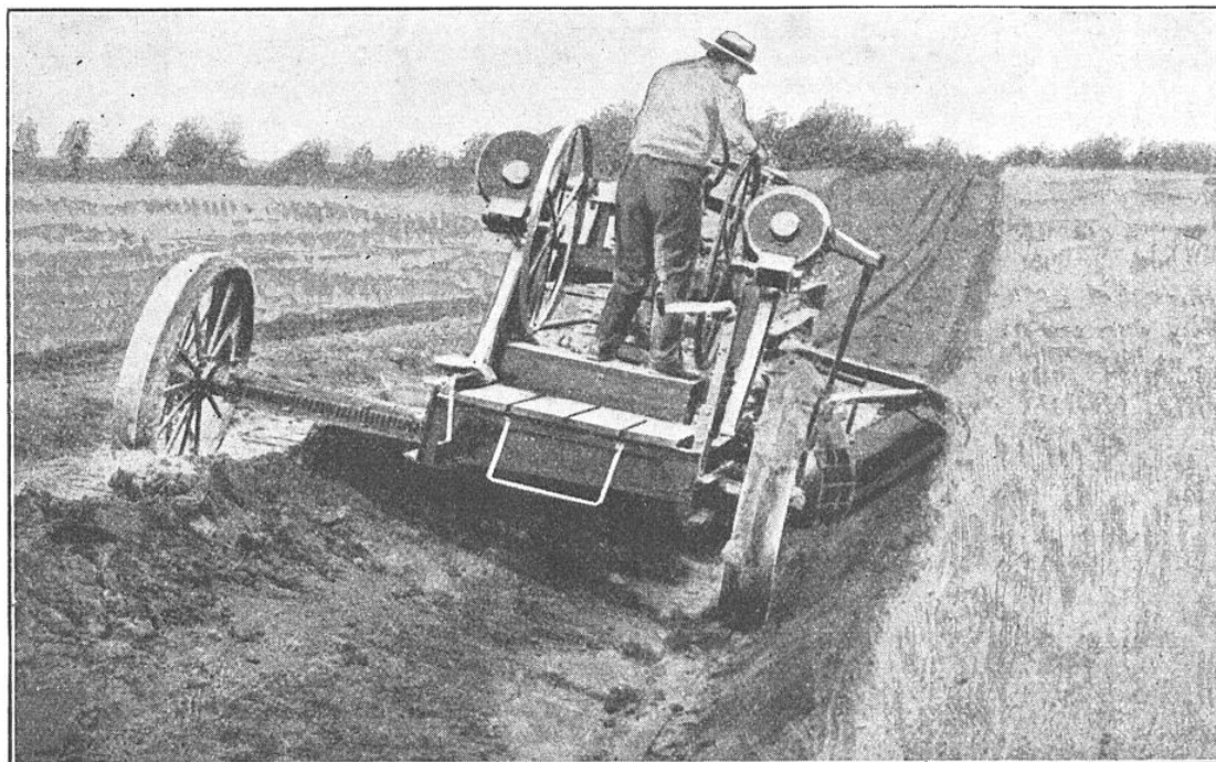
MACHINE AMÉRICAINE PERMETTANT L'EXÉCUTION RAPIDE DES FOSSÉS DESTINÉS À L'ÉCOULEMENT DES EAUX OU DE RIGOLES LONGITUDINALES DANS LES FONDATIONS DE CHAUSSÉES NOUVELLES, POUR EN ASSURER LA CONSERVATION
