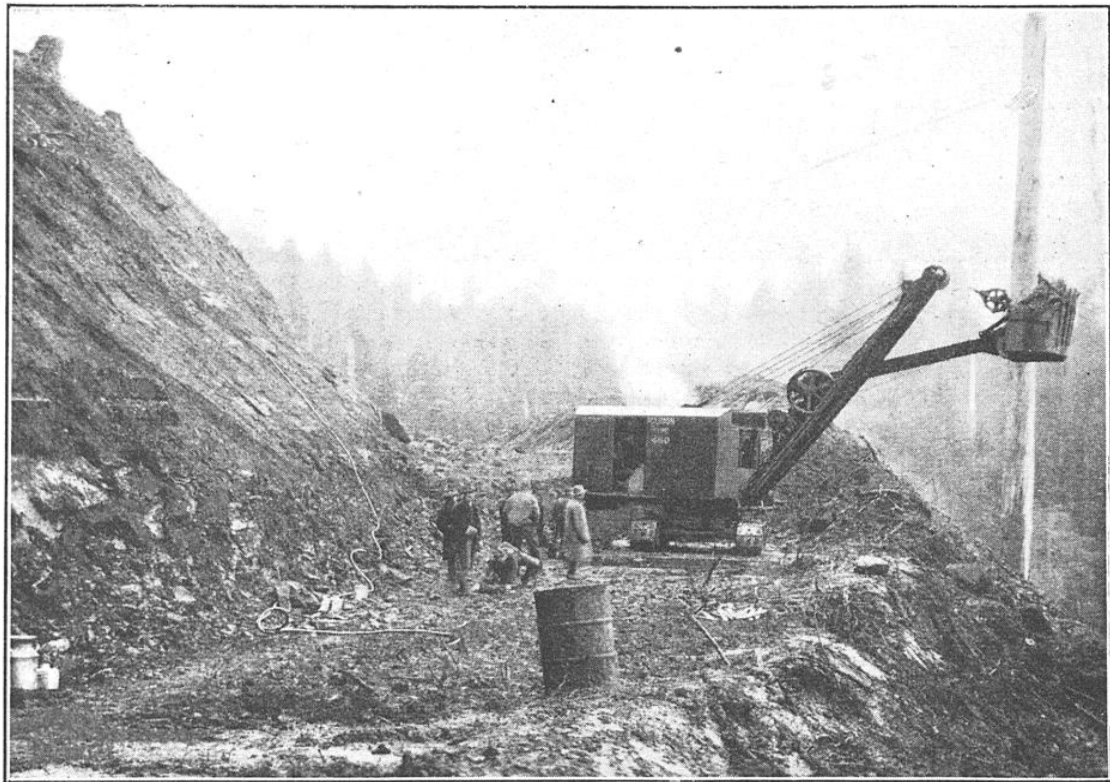
PELLE DRAGUEUSE DIESEL-ÉLECTRIQUE DE 1 MÈTRE CUBE, SERVANT A L'ÉTABLISSEMENT D'UNE PISTE, AUX ÉTATS-UNIS
