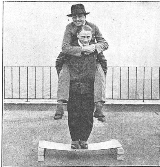
FIG. 12. — UNE GLACE DE PARE-BRISE EN « SÉCURIT », POSÉE SUR DEUX TASSEaux, SUPPORTE, SANS SE BRISER, LE POIDS DE DEUX HOMMES APPLIQUÉ EN SON MILIEU
