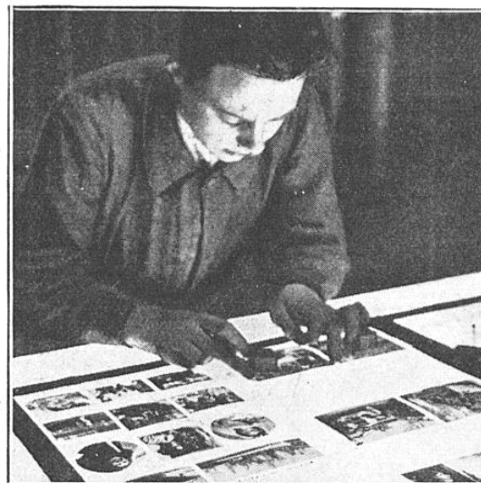
FIG. 6. — LE MONTAGE DE LA FORME LUMINEUSE SUR TABLE DE VERRE
