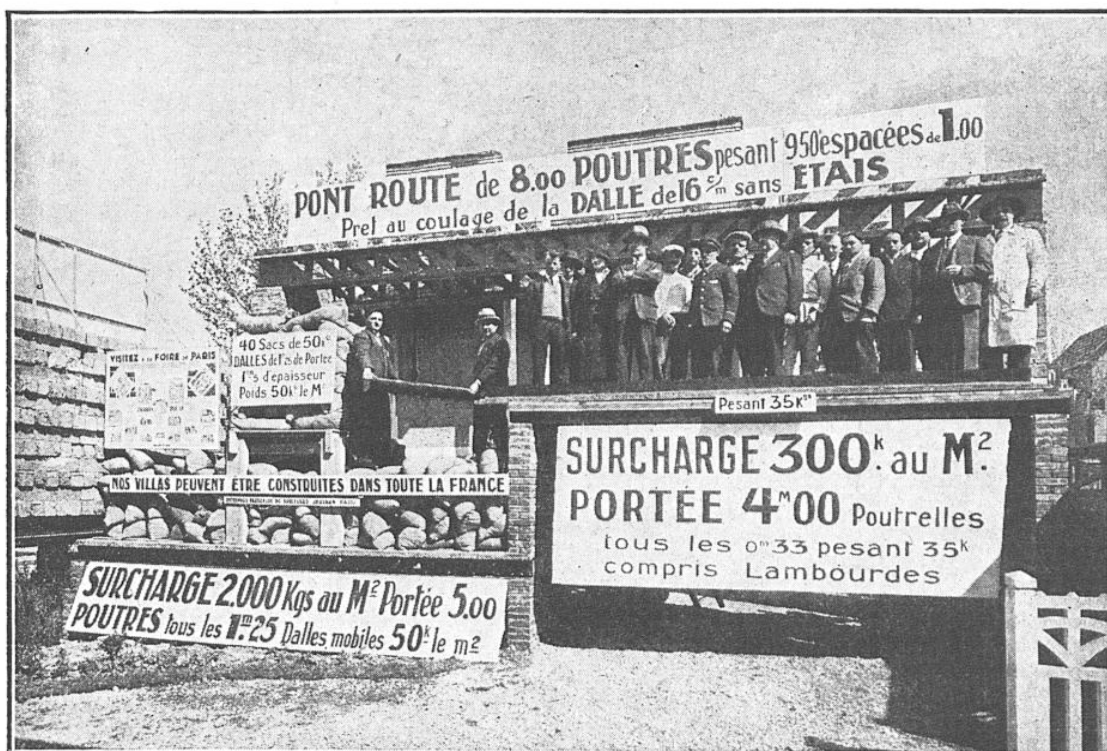
FIG. 3. — VUE D'ENSEMBLE, PRISE A LA FOIRE DE PARIS, MONTRANT UN PONT-ROUTE, UN PLANCHER D'HABITATION, UN PLANCHER D'USINE A DALLES, MODÈLE DE 1 CM 5 D'ÉPAISSEUR, PESANT 42 KILOGRAMMES PAR MÈTRE CARRÉ ET POUVANT SUPPORTER, A LA LIMITE ÉLASTIQUE, UNE CHARGE DE 2.000 KILOGRAMMES PAR MÈTRE CARRÉ
