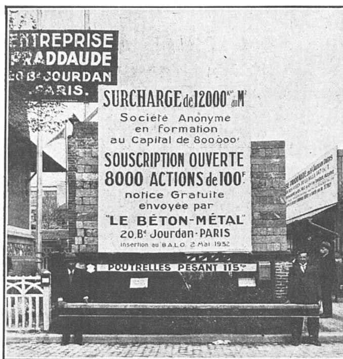
FIG. 1. — VUE, PRISE A LA FOIRE DE PARIS, MONTRANT UN PLANCHER CHARGÉ A 12.000 KILOGRAMMES PAR MÈTRE CARRÉ
