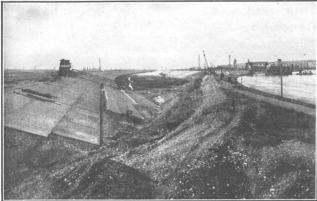
FIG. 4. — LE CANAL D'AMENÉE, DESTINÉ À ALIMENTER L'USINE ET À FACILITER LA NAVIGATION, PEU DE TEMPS AVANT SON ACHÈVEMENT
