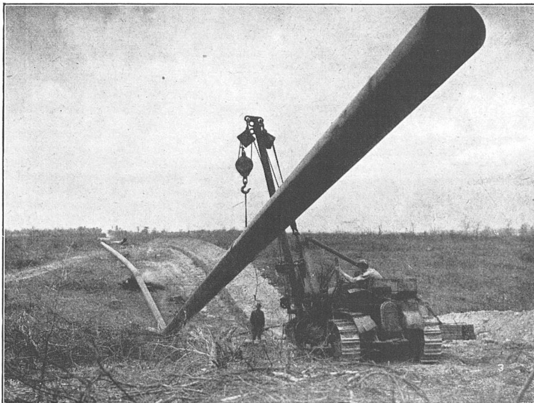
FIG. 6. — PAR OPPOSITION A LA PIPE-LINE SOUS-MARINE, VOICI COMMENT ON POSE UNE PIPE-LINE TERRESTRE, EN VIRGINIE (E.-U.)
