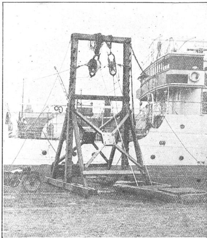
FIG. 5. — LE CHARGEMENT DU CÂBLE A BORD DU NAVIRE CÂBLIER « AMPÈRE »
