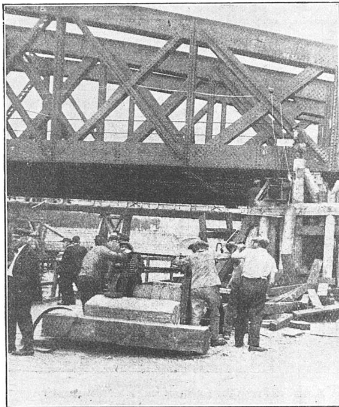
FIG. 3. — LE DÉPLACEMENT DU PONT A ÉTÉ RÉALISÉ AU MOYEN DE SIX TREUILS MUS A LA MAIN
