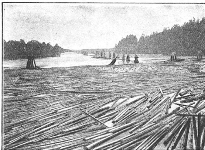
FIG. 5. - BARRAGE DE RETENUE SUR UNE RIVIÈRE DE SUÈDE Ce barrage permet de faire le triage des troncs d'arbres.
