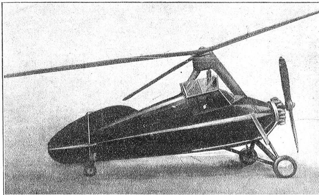
FIG. 2. — LE NOUVEAU TYPE D'AUTOGIRE, AVEC LEQUEL S'EST PRODUIT L'ACCIDENT, NE COMPORTE PLUS DE PLAN FIXE
