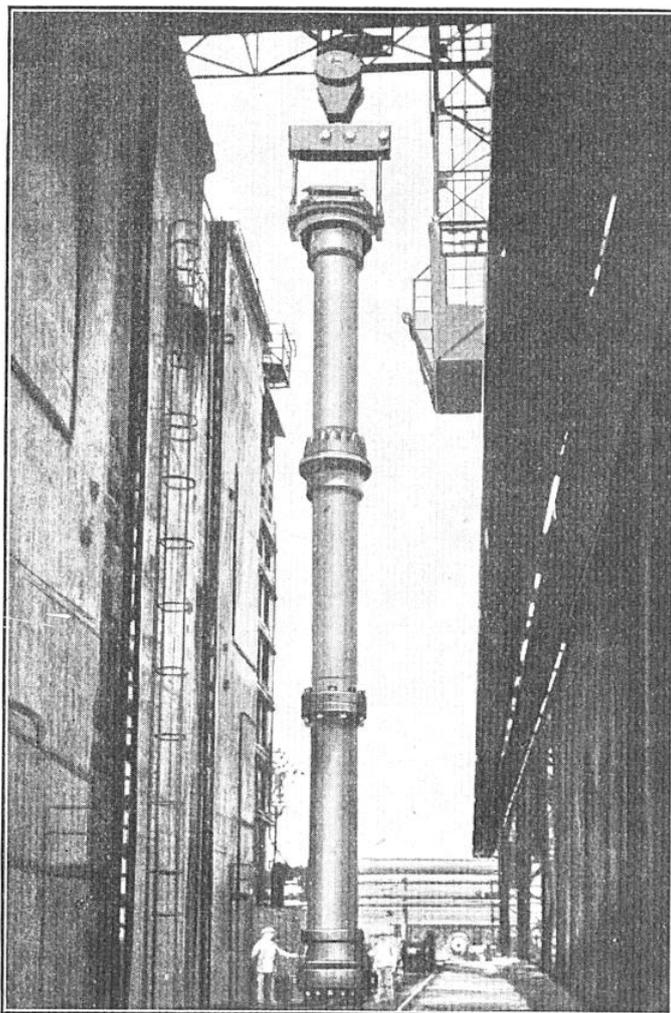
FIG. 3. — UN CATALYSEUR DANS LEQUEL S'EFFECTUE LA SYNTHÈSE DE L'AMMONIAQUE
