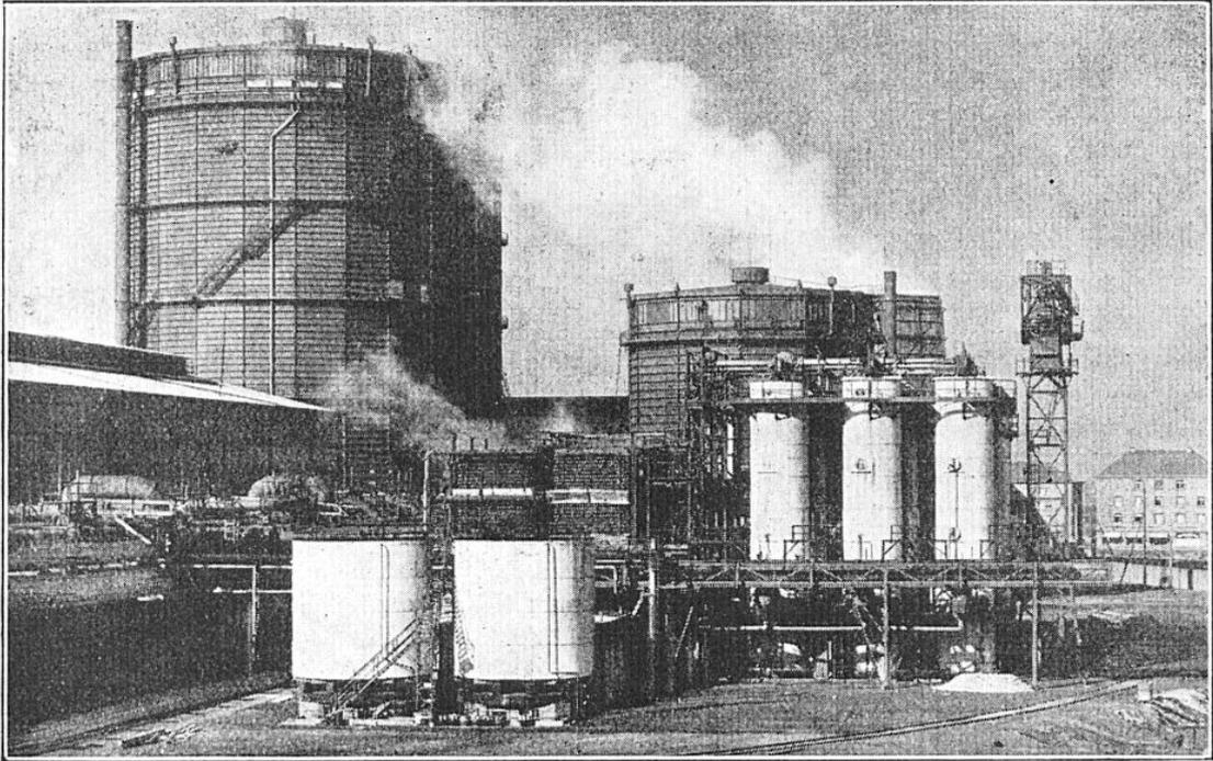
FIG. 8. — BATTERIE DE GAZOMÈTRES NE COMPORTANT AUCUN JOINT HYDRAULIQUE
