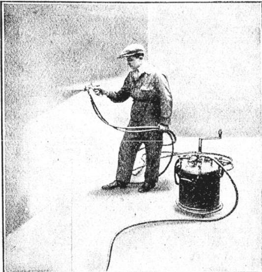
**L**ES étonnants résultats obtenus par les procédés de peinture à l'air comprimé ou « au pistolet », pour la peinture d'automobiles, meubles et tous objets manufacturés, ainsi que des habitations, ouvrages d'art, usines, etc..., ont nécessité la création de machines à peindre parfaitement adaptées à chacun des cas envisagés.
