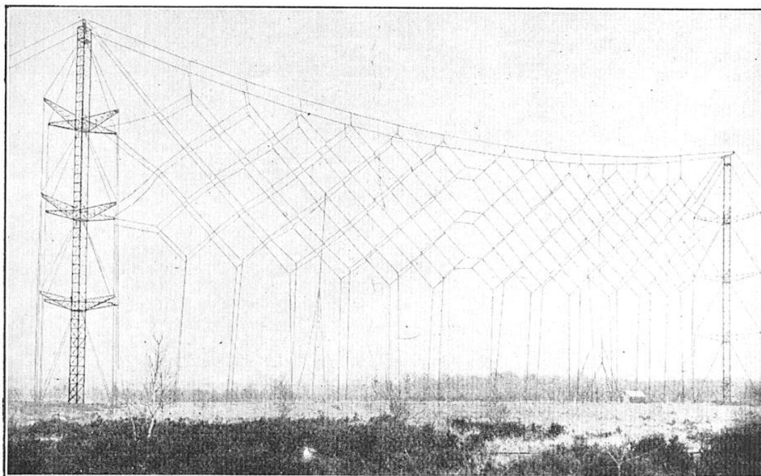
FIG. 8. — ANTENNE EN RIDEAU, SOUTENUE PAR DEUX PYLONES DE 75 MÈTRES, ET RÉFLECTEUR POUR ONDES DE 16 M 44 (CENTRE RADIOTÉLÉGRAPHIQUE DE SAINTE-ASSISE) *Le rideau est divisé en deux parties, alimentées chacune au milieu par des feeders venant du même oscillateur. Le réflecteur arrête l'émission dans le sens opposé à celui de la direction utile.*
