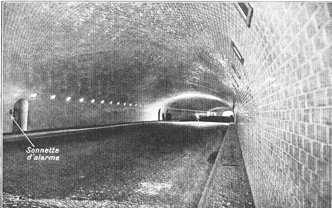
FIG. 3. — VOICI L'ÉCLAIREMENT « A GIORNO », A 242 LAMPES DE 500 WATTS, DU SOUTERRAIN
