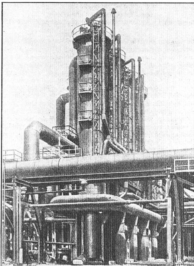
FIG. 14. — TOURS A RUISSELLEMENT POUR LE LAVAGE DU GAZ A L'EAU UTILISÉ POUR LA PRÉPARATION DE L'AMMONIAQUE DE SYNTHÈSE
