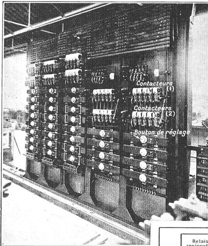
FIG. 6. — LES RELAIS DE COMMANDE INSTALLÉS DANS UNE CHAMBRE SPÉCIALE, ANNEXE DU SOUTERRAIN
