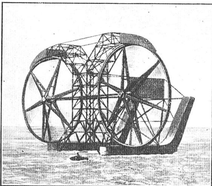
FIG. 4. — PROJET DE CENTRALE ÉOLIENNE MARINE DE 200 MÈTRES DE HAUT POUR L'UTILISATION DES VENTS DE L'ATLANTIQUE, DONT LA VITESSE MOYENNE, A CETTE HAUTEUR, ATTEINT 8 MÈTRES A LA SECONDE
