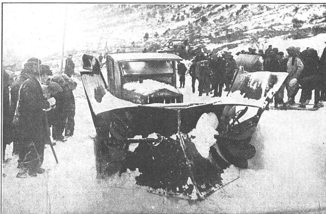
FIG. 5. — LE PLUS PUISSANT CHASSE-NEIGE AMÉRICAIN A TURBINES LATÉRALES QUI A RÉUSSI A SE FRAYER UN PASSAGE SUR UNE ROUTE RECOUVERTE DE 3 MÈTRES DE NEIGE
