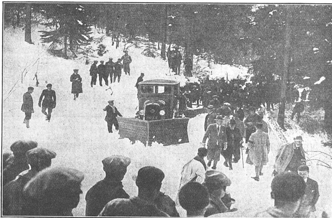
FIG. 3. — LE CHASSE-NEIGE A ÉTRAVE, EN ACTION SUR UNE ROUTE RECOUVERTE D'UNE FAIBLE ÉPAISSEUR DE NEIGE, REMPLIT PARFAITEMENT SA FONCTION
