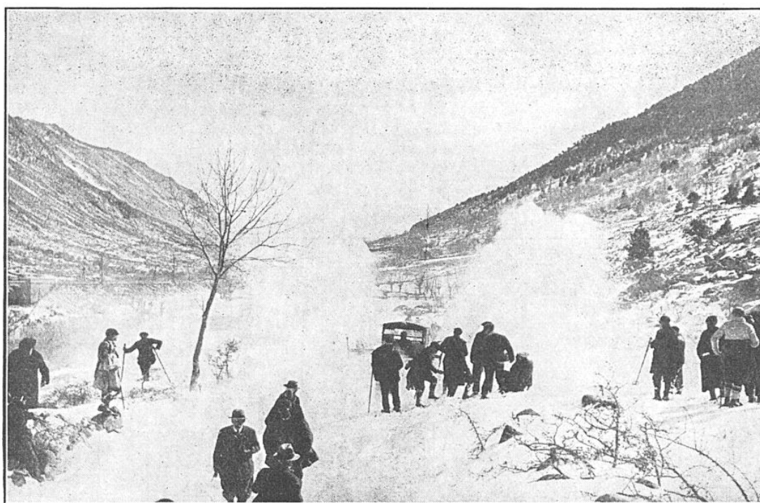
FIG. 6. — CHASSE-NEIGE ITALIEN A TURBINES, EN ACTION, REJETANT LA NEIGE A GRANDE DISTANCE DES DEUX COTÉS DE LA ROUTE
