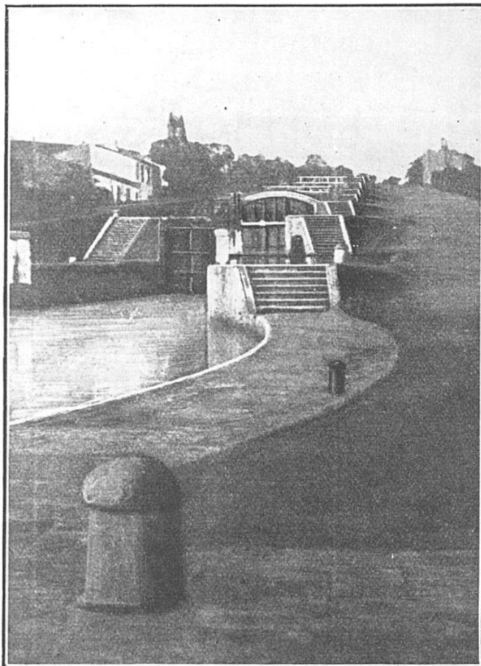
FIG. 1. — LE CANAL DU MIDI FRANCHIT UNE COLLINE AU MOYEN DE NEUF ÉCLUSES CONSÉCUTIVES, A BÉZIERS
