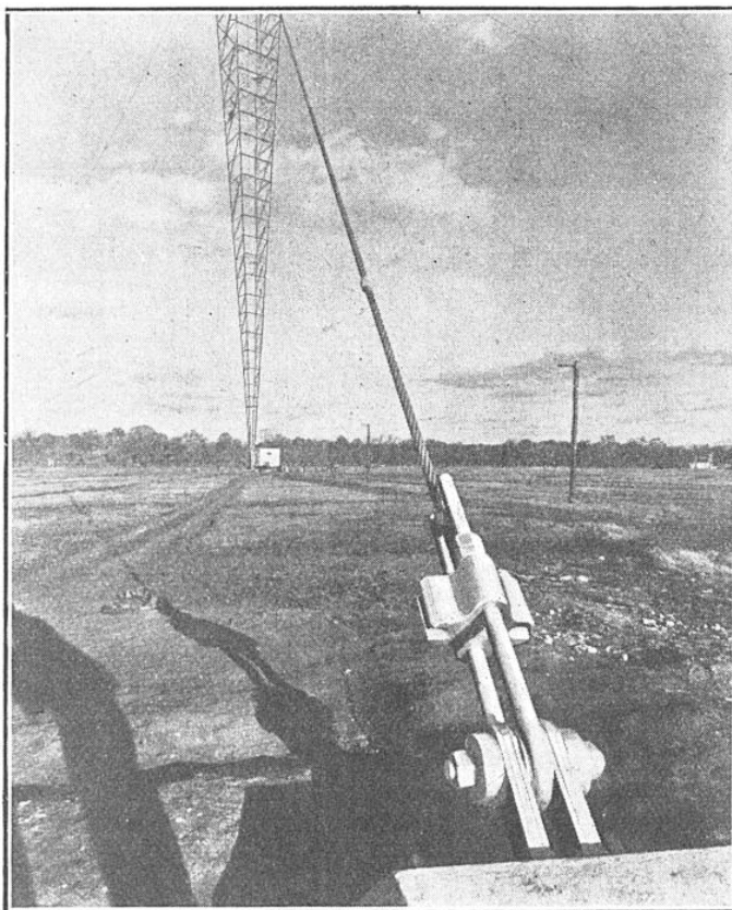
FIG. 4. — DISPOSITIF D'ANCRAGE ET DE TENSION D'UN DES HUIT HAUBANS MAINTENANT L'ANTENNE CONSTITUÉE PAR UN PYLÔNE RAYONNANT DE 267 MÈTRES DE HAUT DE LA STATION DE NASHVILLE (TENNESSEE, ÉTATS-UNIS)
