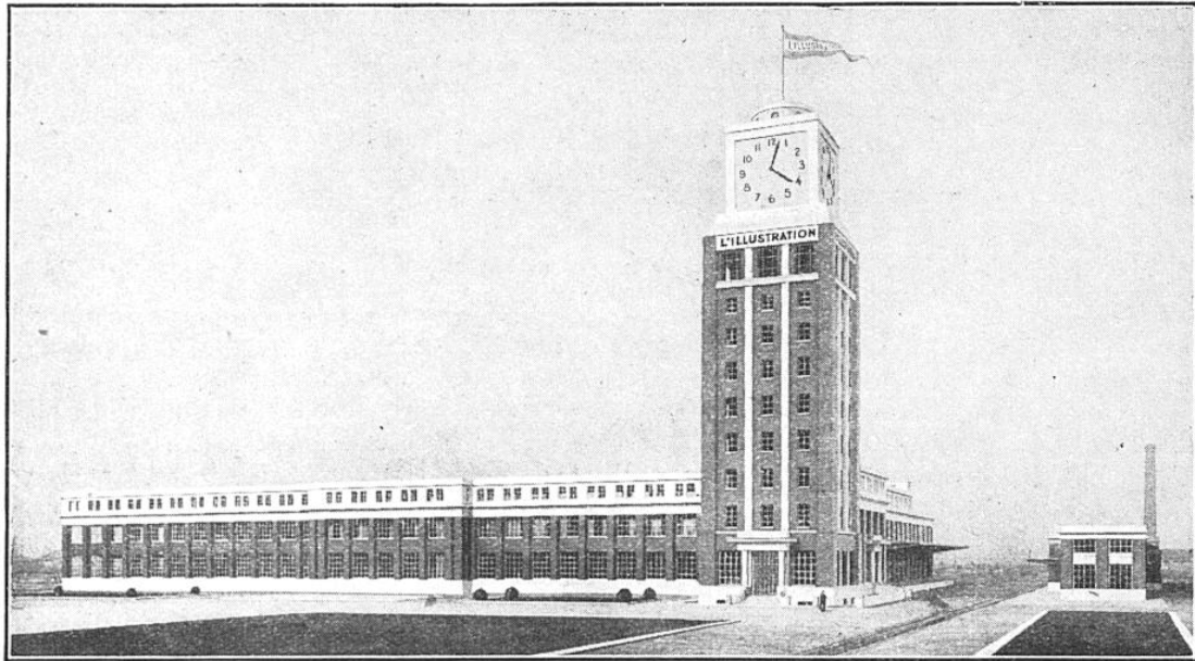
FIG. 1. — VUE GÉNÉRALE DE LA NOUVELLE IMPRIMERIE DE « L'ILLUSTRATION », A BOBIGNY Elle est dominée par une tour de 64 mètres, que couronne une horloge géante dont le cadran ne mesure pas moins de 7 m 50. Les bâtiments couvrent une surface de 1 hectare et demi.
