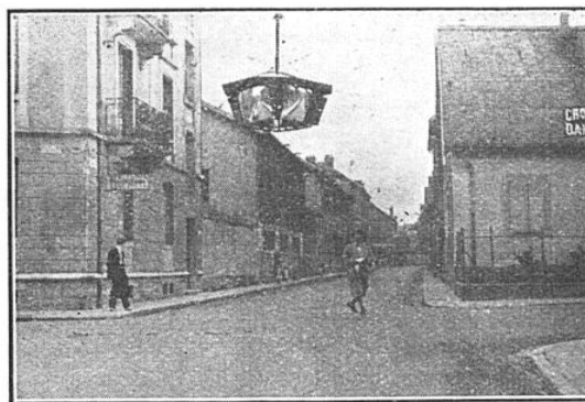
LA LANTERNE MUNIE DE GLACES, PLACÉE A UN CARREFOUR, MONTRE SI UN VÉHICULE ARRIVE PAR UNE VOIE TRANSVERSALE
