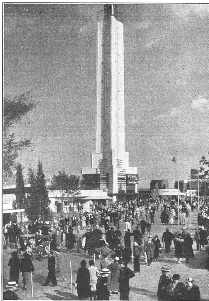
FIG. 3. — UN THERMOMÈTRE DE 60 MÈTRES DE HAUT Dans ce thermo mètre, une des attractions de l'Exposition, les degrés étaient indiqués par des tubes au néon, eux-mêmes commandés par un thermomètre à mercure placé à la base du bâtiment.
