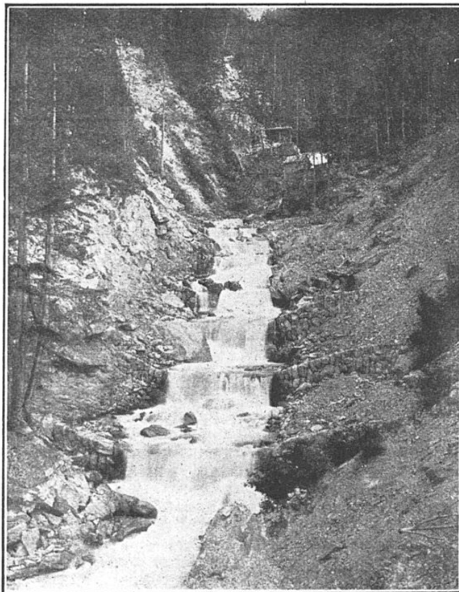
FIG. 6.— COMMENT ON RÉGULARISE LE COURS DE CERTAINS TORRENTS A L'AIDE D'UNE SUCCESSION DE BARRAGES (VOIR « LA SCIENCE ET LA VIE », N° 158, PAGE 104)
