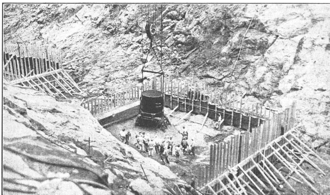
FIG. 6. — ON PROCÈDE AU BÉTONNAGE D'UN DES PILIERS — DONT LA RÉUNION FORMERA LE BARRAGE « HOOVER » — AU MOYEN DE CAISSES A FOND MOBILE Cette photographie représente le moment précis où la caisse, en s'ouvrant, laisse échapper le béton.
