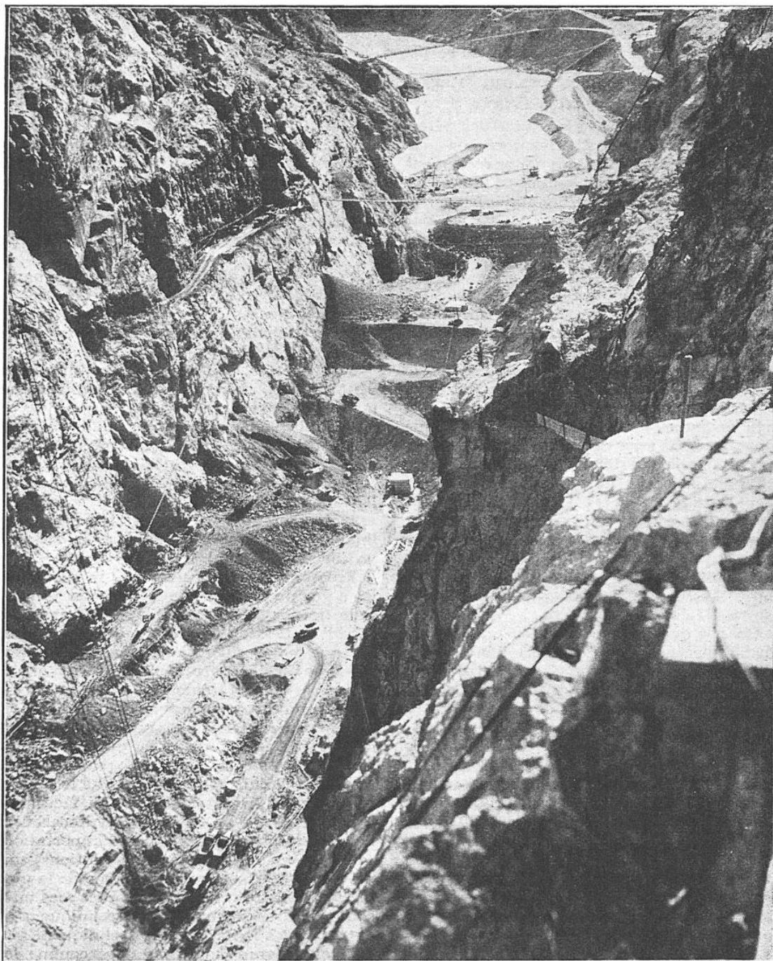
UNE RÉCENTE PHOTOGRAPHIE DES GIGANTESQUES TRAVAUX ENTREPRIS SUR LE COLORADO (ÉTATS-UNIS) POUR L'ÉDIFICATION DU BARRAGE « HOOVER »
