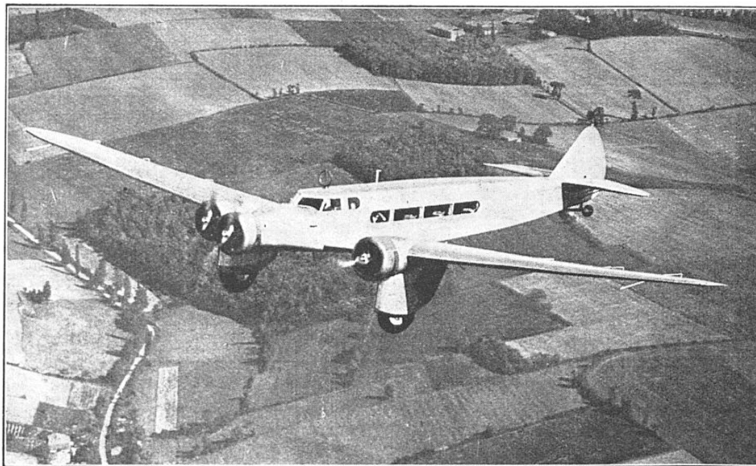
FIG. 4. — LE TRIMOTEUR DE TRANSPORT A GRAND RAYON D'ACTION « DEWOITINE 332 » Cet appareil, entièrement métallique, dont le poids total dépasse 9 tonnes et dont la vitesse est de 265 kilomètres à l'heure, est au nombre de ceux qui pourraient assurer la liaison transatlantique.
