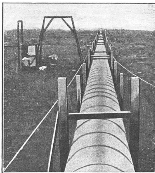
FIG. 6. — VOICI LE TUBE A VIDE DE UN MILLE DE LONG (1.609 MÈTRES), QUI A SERVI AUX DERNIÈRES EXPÉRIENCES DE MICHELSON ET DE SES SUCCESEURS
