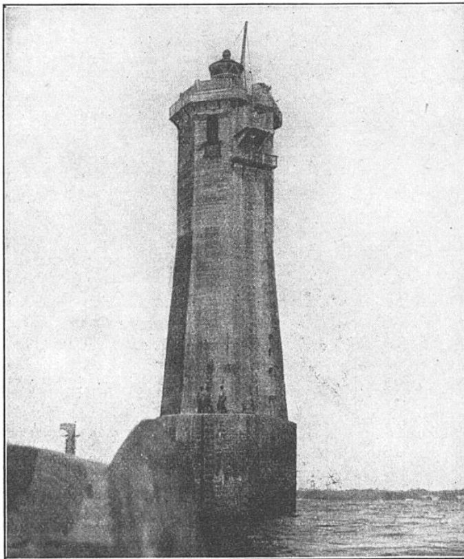
FIG. 6. — ASPECT EXTÉRIEUR DE LA TOUR DE NIVIDIC AVANT L'ACCROCHAGE DES CÂBLES TRANSPORTEURS
