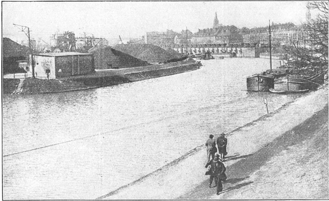
FIG. 2. — VUE GÉNÉRALE DU PORT CHARBONNIER SUR LE CANAL, A SARREBRÜCK
