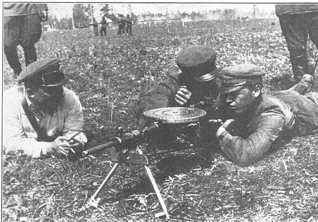
FIG. 1. — L'INFANTERIE RUSSE A CONSERVÉ SON FUSIL DE 7 \frac{m}{m} 62 ET LA MITRAILLEUSE « MAXIM » DE MÊME CALIBRE, QU'ELLE UTILISAIT DÉJÀ EN 1914. ELLE POSSÈDE, EN OUTRE, PLUSIEURS TYPES DE FUSILS-MITRAILLEURS, COMME LE « FEDOROV » DE 6 \frac{m}{m} 5, LE « MADSSEN » ET AUSSI LE « DEGZAROFF », QUI NE PÈSE QUE 7 KG 700
