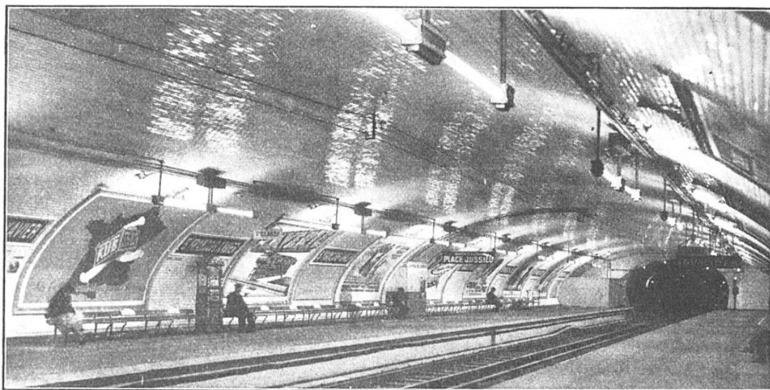
A PARIS, LA STATION DU MÉTRO « SAINT-FRANÇOIS-XAVIER » EST ÉCLAIRÉE EN LUMIÈRE BLANCHE AU MOYEN DE GROUPES FORMÉS PAR UN TUBE DE VERRE DÉPOLI CONTENANT UN TUBE LUMINESCENT AU NÉON (ROUGE) ET UN TUBE FLUORESCENT (VERT)
