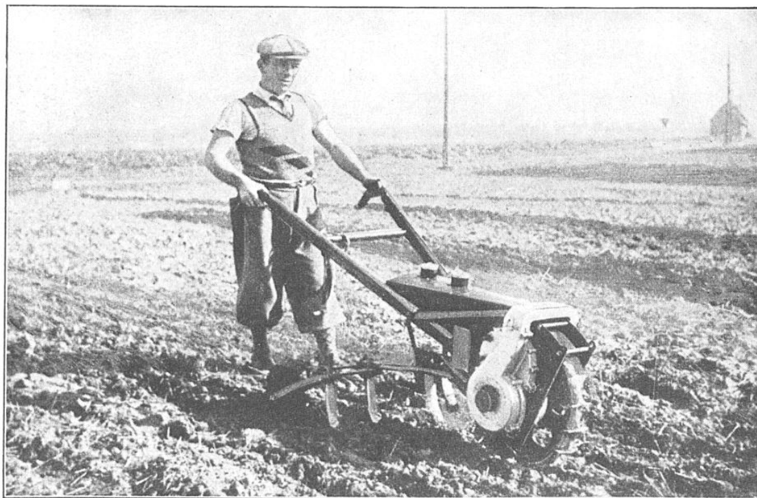
FIG. 1. — CETTE BINEUSE A MOTEUR, DESTINÉE A L'ENTRETIEN DU SOL DANS TOUTES LES CULTURES EN LIGNES, EST UTILISÉE ICI POUR LE DÉCHAUMAGE
