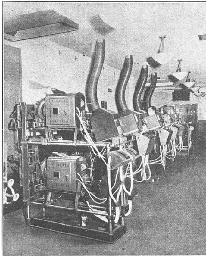
FIG. 7. — LA CABINE ET LES APPAREILS DE PROJECTION DU CINÉMA « ROXY », A NEW YORK
