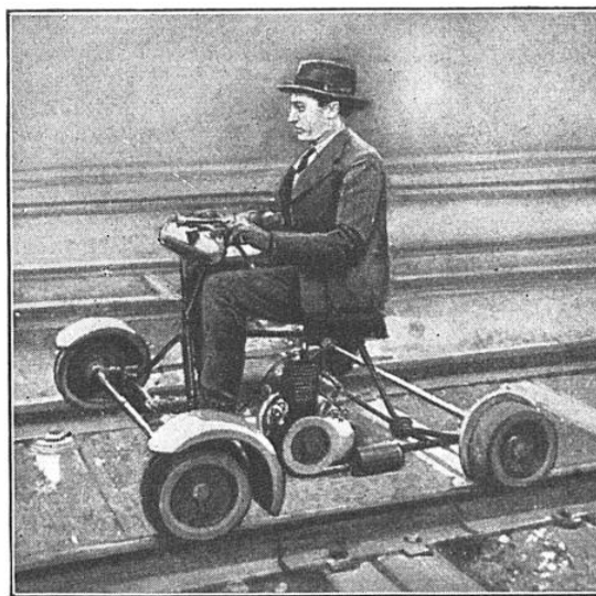
MOTORAIL POUR L'INSPECTION DES VOIES
