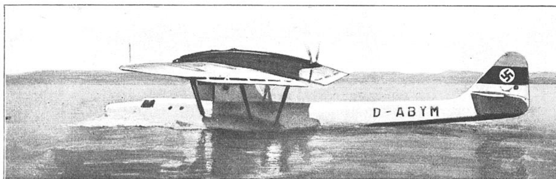
FIG. 5. — CET HYDRAVION ALLEMAND CATAPULTABLE « DORNIER-18 » ÉQUIPÉ DE DEUX MOTEURS « JUMO-205 » A HUILE LOURDE DE 600 CH A EFFECTUÉ RÉCEMMENT LA PREMIÈRE TRAVERSÉE COMMERCIALE D'ESSAI SUR LA LIGNE DE L'ATLANTIQUE-NORD
