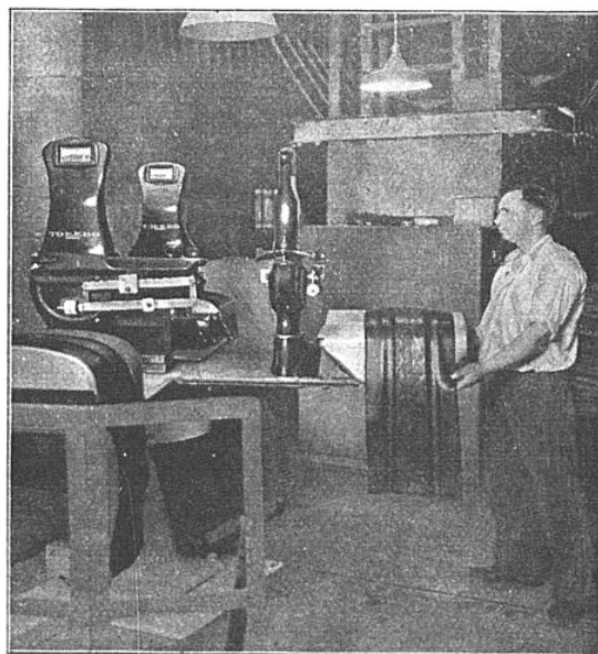
FIG. 7. — LA VÉRIFICATION DU POIDS ET DE L'UNIFORMITÉ DES BANDES DE ROULEMENT
