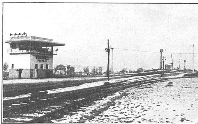
FIG. 1. — VOICI LA « BUTTE » DE TRAPPES-TRIAGE, AVEC LES VOIES DESCENDANTES ET LES PREMIÈRES AIGUILLES. A gauche, la cabine vitrée du chef de butte, surmontée de quatre haut-parleurs. La butte de triage est au fond à droite.
