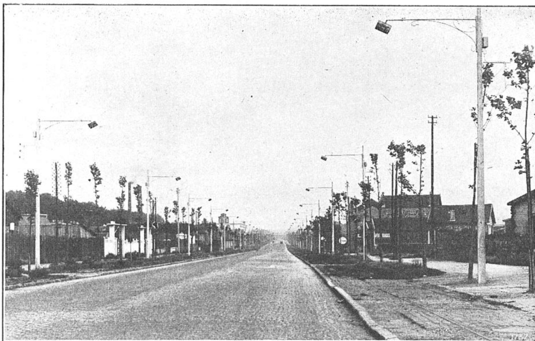
FIG. 3. — LA ROUTE NATIONALE N° 3 A LA SORTIE DE PARIS, ENTRE BOBIGNY ET NOISY-LE-SEC, EST ÉQUIPÉE DE LAMPADAIRES PORTANT DES LAMPES A VAPEUR DE SODIUM
