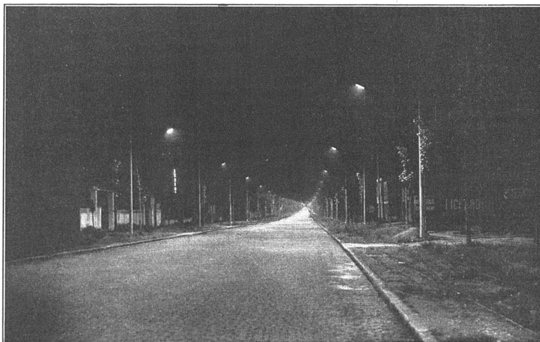
FIG. 4. — VOICI CETTE MÊME ROUTE NATIONALE N° 3 PHOTOGRAPHIÉE DE NUIT AVEC LES TUBES A VAPEUR DE SODIUM EN FONCTIONNEMENT PROTÉGÉS PAR DES RÉFLECTEURS
