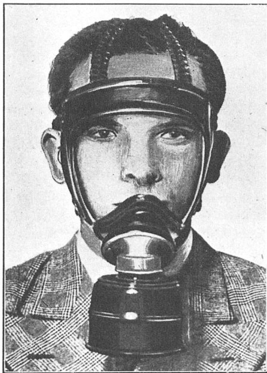
FIG. 2. — UN DES DIX-HUIT MODÈLES DE MASQUES FRANÇAIS AGRÉÉS PAR LES SERVICES DE LA GUERRE (TYPE A VISIBILITÉ INTÉGRALE)
