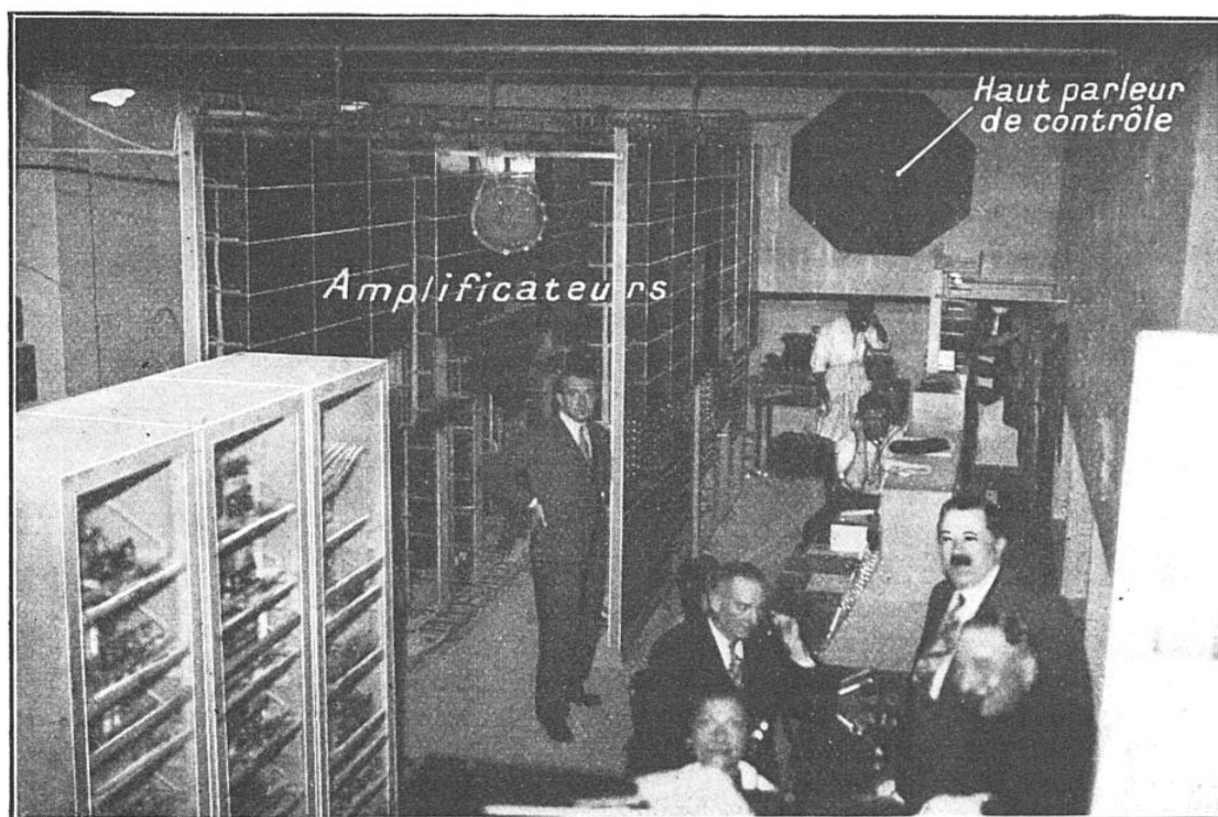
FIG. 6. — VUE DE LA SALLE DES AMPLIFICATEURS
