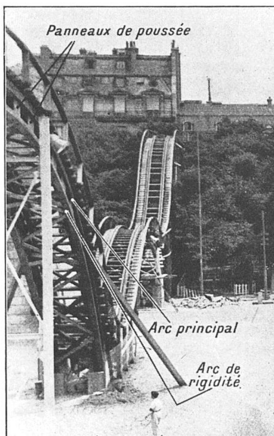
FIG. 1. — VOICI UNE PARTIE DE LA VOIE DU « SCENIC RAILWAY » MONTRANT LA NAISSANCE DE LA GRANDE ARCHE
