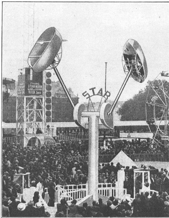
FIG. 6. — VUE D'ENSEMBLE DU « LOOPING STAR » Les deux nacelles oscillent symétriquement et s'arrêtent quelques secondes au point haut de leur course ( looping arrêté ).
