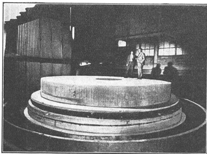
FIG. 6. — LE DISQUE DE 5 MÈTRES DE DIAMÈTRE TEL QU'IL APPARAÎSSAIT À SA SORTIE DU REFROIDISSEUR, AVANT LES PREMIERS ESSAIS OPTIQUES
