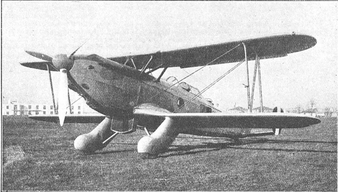
FIG. 4. — LE « CA.-134 », BIPLAN MONOMOTEUR DE RECONNAISSANCE EN BOIS, TOILE ET MÉTAL. Cet appareil à deux places, propulsé par un moteur de 813 ch à l'altitude de 4 500 m, possède une autonomie de 1 100 km. Sa vitesse maximum atteint 390 km/h (vitesse de croisière, 345 km/h). Il peut s'élever à 5 000 m en 13 mn 30 s et son plafond est de 7 000 m.
