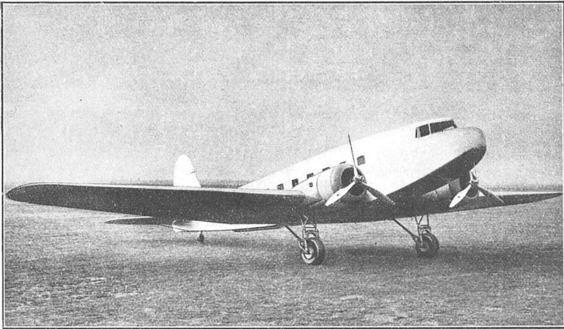
FIG. 7. — LE BIMOTEUR DE TRANSPORT «G.-18 V», ENTIÈREMENT MÉTALLIQUE
