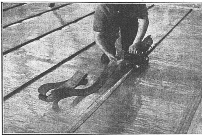
FIG. 2. — MISE EN PLACE D'UN COUVRE-JOINT
