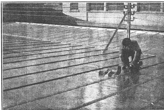
FIG. 3. — VOICI LA TOITURE RECOUVERTE DE PAXALUMIN
