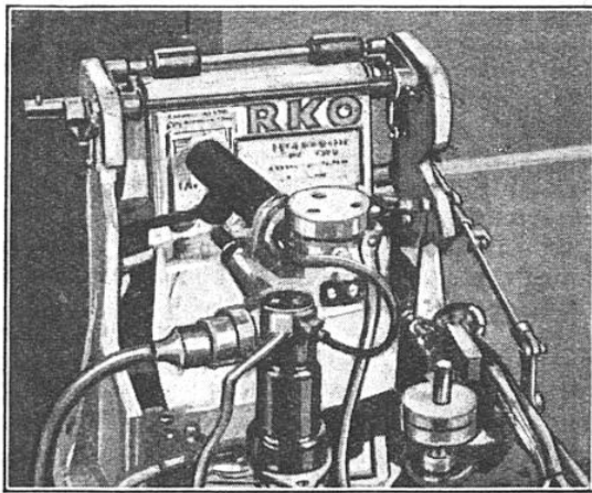
FIG. 1 ET 2. — TYPES D'ÉMETTEUR (A GAUCHE) ET DE RÉCEPTEUR (A DROITE) UTILISÉS AUX ÉTATS-UNIS POUR LA REPRODUCTION DES JOURNAUX A DOMICILE
