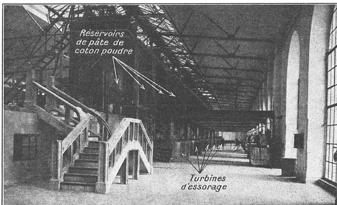
FIG. 6. — VUE D'UN ATELIER DE FABRICATION DU COTON-POUDRE (USINE ALLEMANDE) A gauche, les grands réservoirs dans lesquels arrive la pâte de coton-poudre stabilisé. Ils sont en charge sur des séries de turbines dans lesquelles s'effectue l'essorage final.
