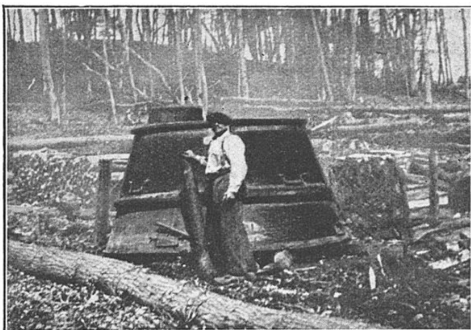
FIG. 1. — MONTAGE D'UN FOUR MÉTALLIQUE POUR LA PRÉPARATION DU CHARBON DE BOIS
