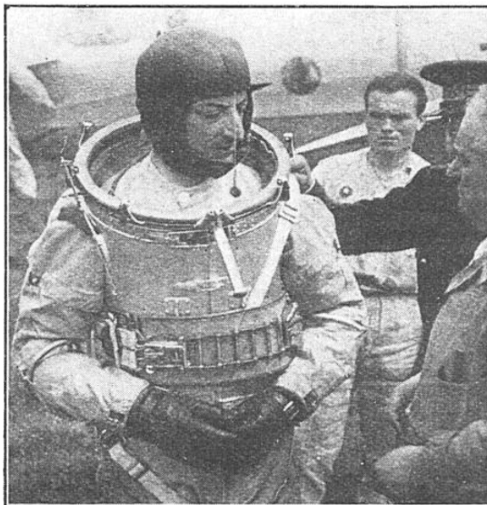
FIG. 5. — LE SCAPHANDRE DU COLONEL ITALIEN PEZZI, AVEC LEQUEL FUT ÉTABLI SON PREMIER RECORD DE 15 655 M
