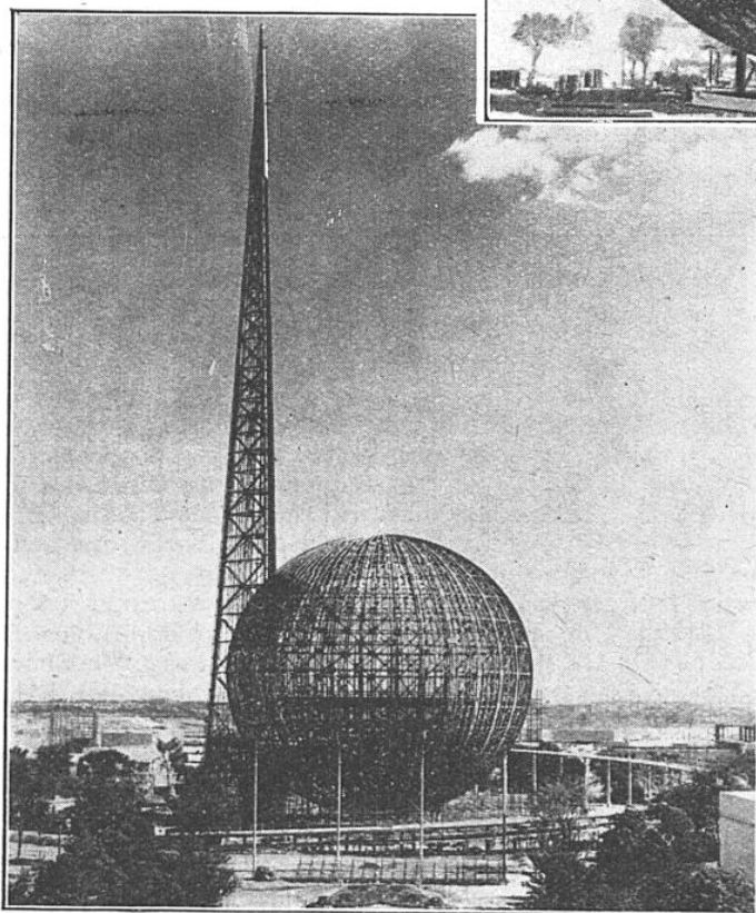
FIG. 4. — LES ARMATURES DE MÉTAL DU « TRYLÔNE » ET DE LA « PÉRISPHERE » SANS LE REVÊTEMENT DE STAFF
