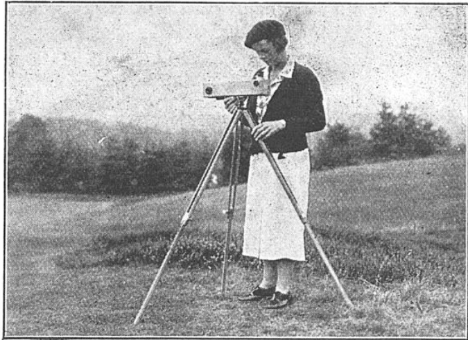
FIG. 4. — TÉLÉMÈTRE DE 30 CM DE LONGUEUR DE BASE POUR RELEVÉS TOPOGRAPHIQUES
