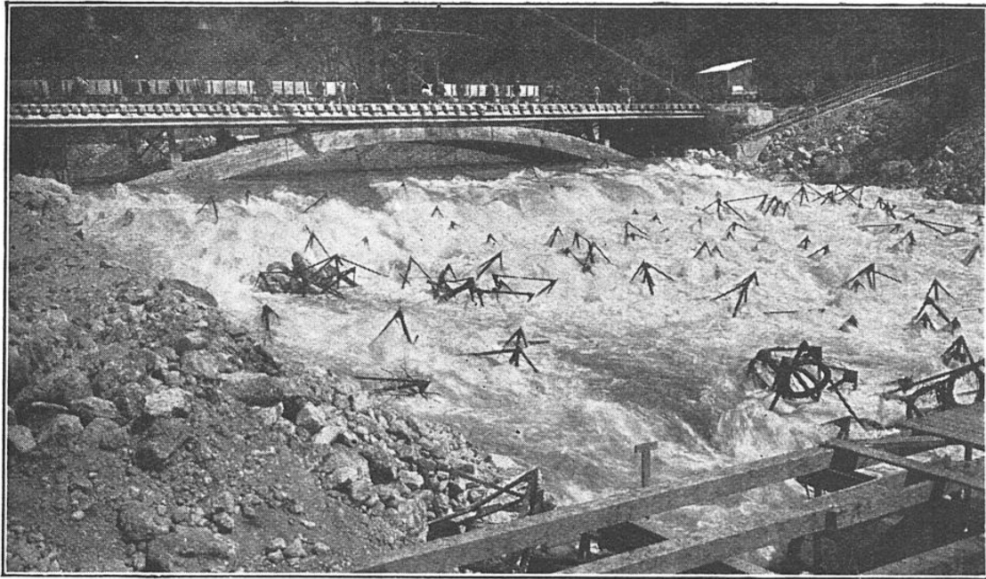
FIG. 6. — LE « PONT DE SERVICE » AMONT AVANT LE DÉBUT DES TRAVAUX DE COUPURE On a encombré le fleuve de « tétraèdres » métalliques. Ces formes géométriques s'accrochent entre elles ou, encore, aux aspérités du lit, sans trop gêner l'écoulement. Là-dessus, on pourra commencer la déjection des premiers matériaux qui assureront la coupure du fleuve.
